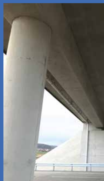
Wiadukt nad drogą ekspresową S3
