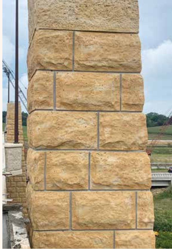
Imitacja kamienia na betonie mostu w Iowa, USA
